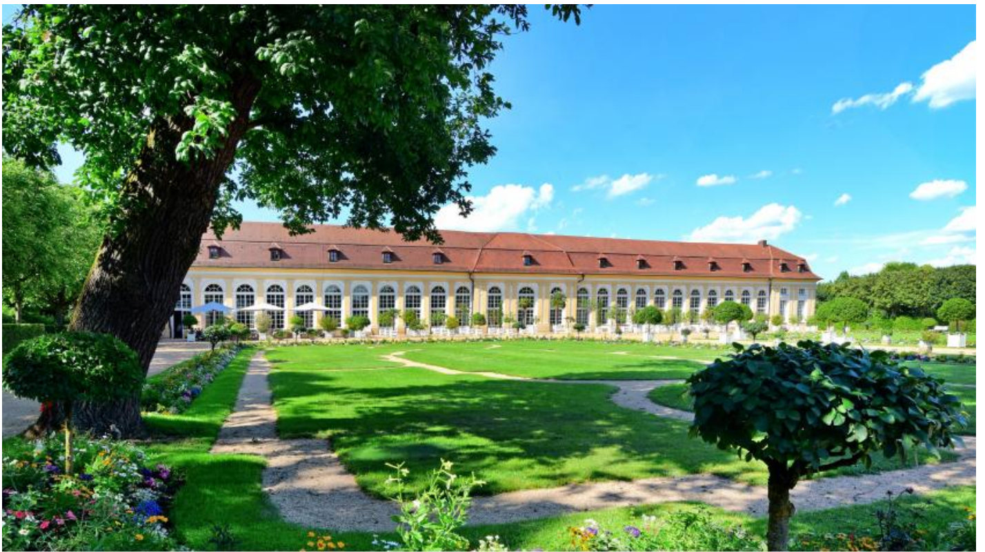
Außenansicht Orangerie Ansbach
