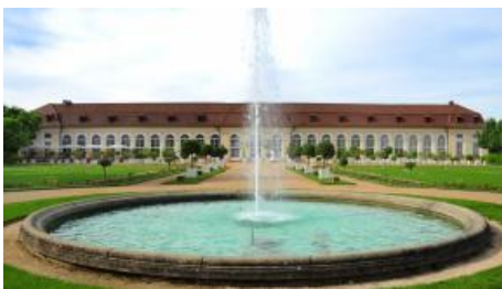
Außenansicht Orangerie Ansbach
