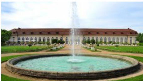
Außenansicht Orangerie Ansbach
