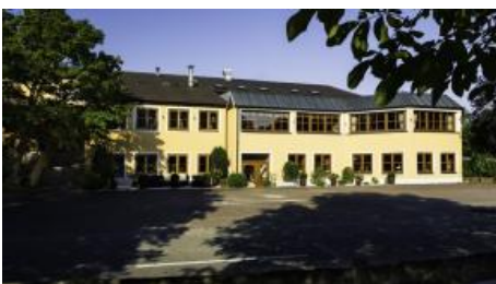
Außenansicht Hallnberg - Hotel, Restaurant und Events
