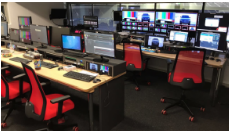
Studiokonzeption und Bau
