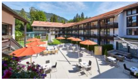
Tagen im Freien - Innenhof
