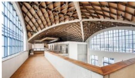
das neue Veranstaltungszentrum marinaforum Regensburg
